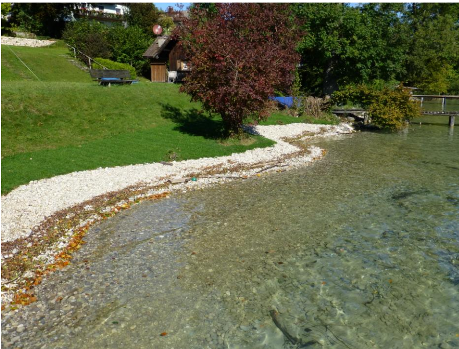
Abb. 4: Flaches, schottriges Ufer nach der Entfernung des Blockwurfs.
