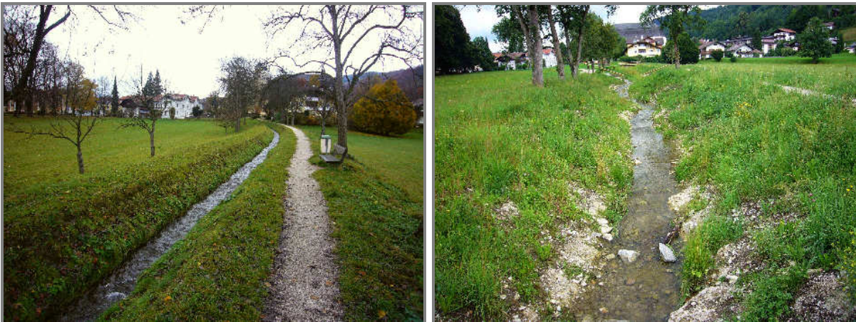
Abb. 6: Die morphologische Ausprägung des Kandlbaches vor (links) und nach (rechts) der Restrukturierung.
