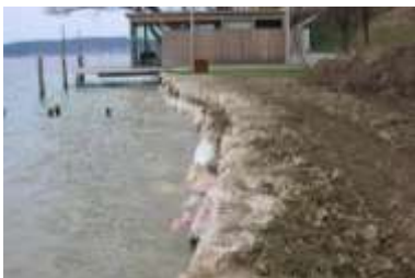
gering: (annähernd) senkrecht verlegte Steinschichtung
