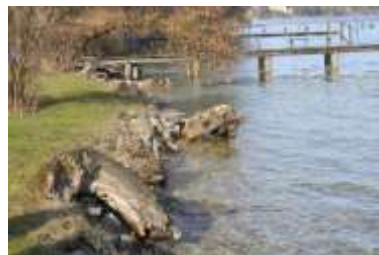
gering: schräg-flach, rau verlegte Steine, Totholz
