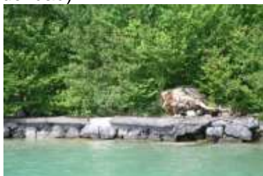
mittel: senkrechte-schräge Steinschichtung, nicht verfugt
